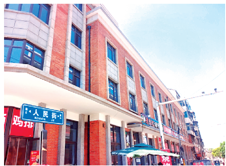
自我市申报国家历史文化名城工作启动以来,淮阳区坚持“修旧如旧、活化利用”的原则,努力将历史文化街区打造成彰显老城烟火气的特色街区。图为修缮后的红旗大楼。记者 侯俊俊 摄
